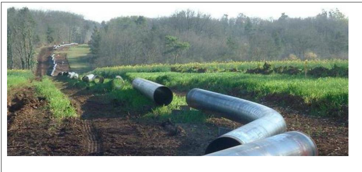
Зураг 1. Дамжуулах хоолойг барих барилгын явц
